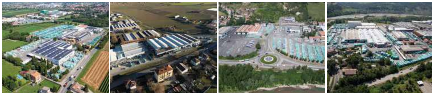
Antica Ceramica Rubiera Uffici, Stabilimento Produttivo e Magazzino (Offices, Production Plant and Warehouse)
